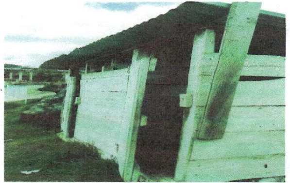
Foto 4: sustitucion de puertas en servicios sanitarios.
