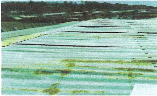
Foto 1: sustitucion de laminas, por lámina troquelada aluzinc calibre 26
