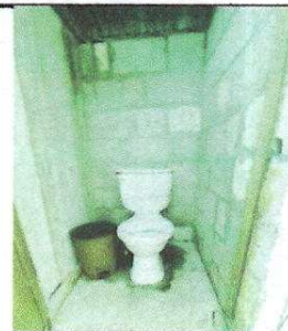
Foto 6: sustitucion de inodoro
