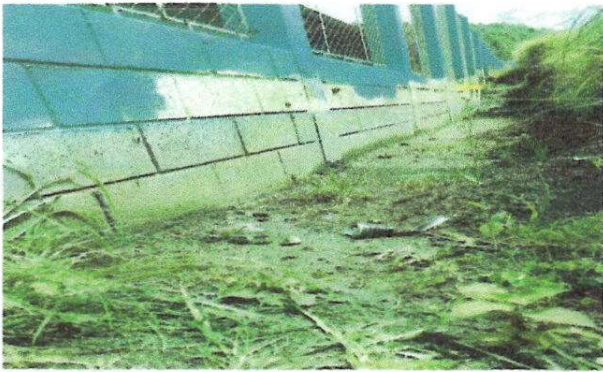
Foto 3: pintura en muro exteriores e interiores.
