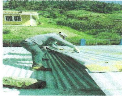
Foto 2: sustitucion de capote de lámina por lámina troquelada
